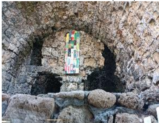
איור 24- חוסר קטעי קיר שלמים היוצרים מחיצות בקמרונות ק.ע..
