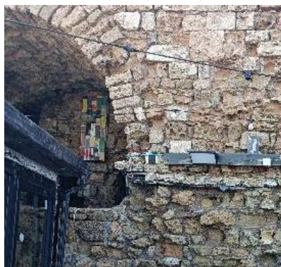
איור 16 - חוסר אבני הגזית בפן החיצוני של קצה הקמרונות והקיר בין הקמרונות
